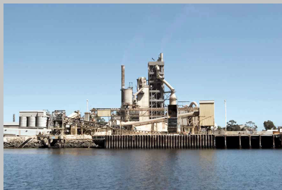
Fabrique de Béton
