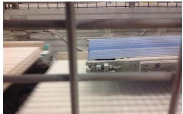
↑ Umlenkrolle eines Tauchbecken-Förderbands
